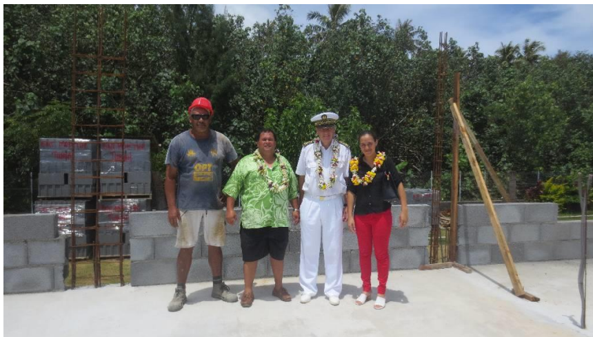
Visite du chantier de reconstruction de l'école maternelle Teina, à Mataura
